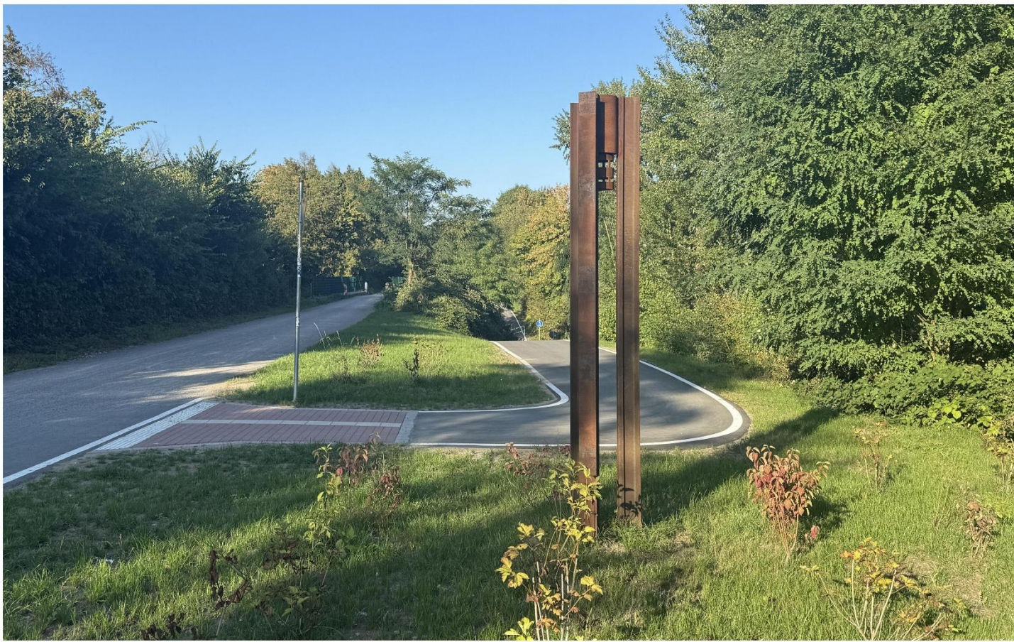
Rampen und Brücke über die Wiemelhauser Straße
